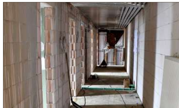
In dem Anbau, der derzeit errichtet wird, finden sowohl die Sanitäranlagen als auch ein Küchenbereich Platz.
