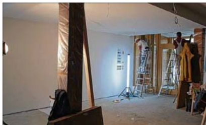
Neue Räume entstehen zurzeit im Benneckensteiner Gotteshaus. Hier Maler und Tischler von Handwerksfirmen aus Elbingerode in einem der neuen Gemeindefreizeitepunkte. Fotos (2): Jürgen Kohlrausch
