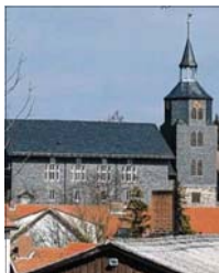
Benneckensteins alte Kirche wird mit viel Aufwand innen neu gestaltet. Foto: Burkhard Falkner
